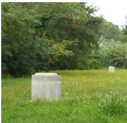
Regard d'exploitation du forage F3
