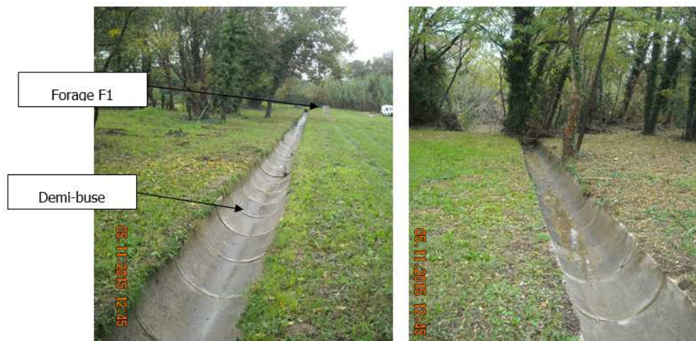
Demi buse béton traversant le PPI et
